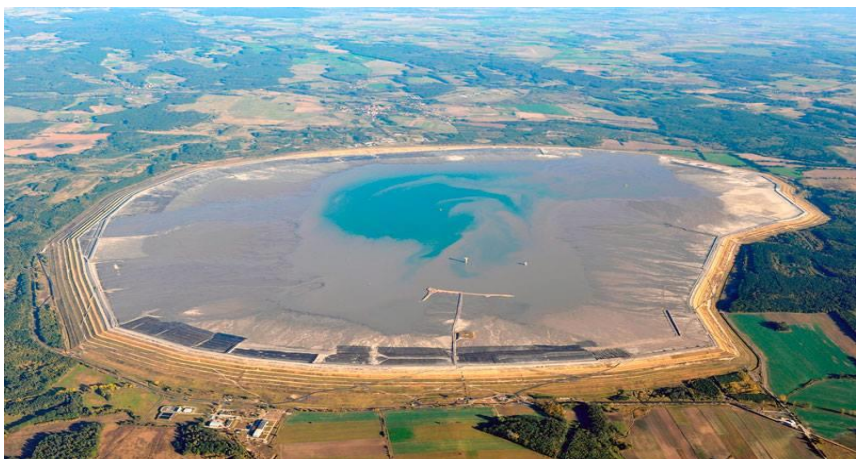
Rysunek 6 Ogólny widok – obiektu unieszkodliwiania odpadów „Żelazny Most” [122]
